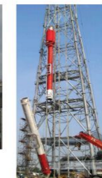
可拆卸高架火炬 dismountable flare
